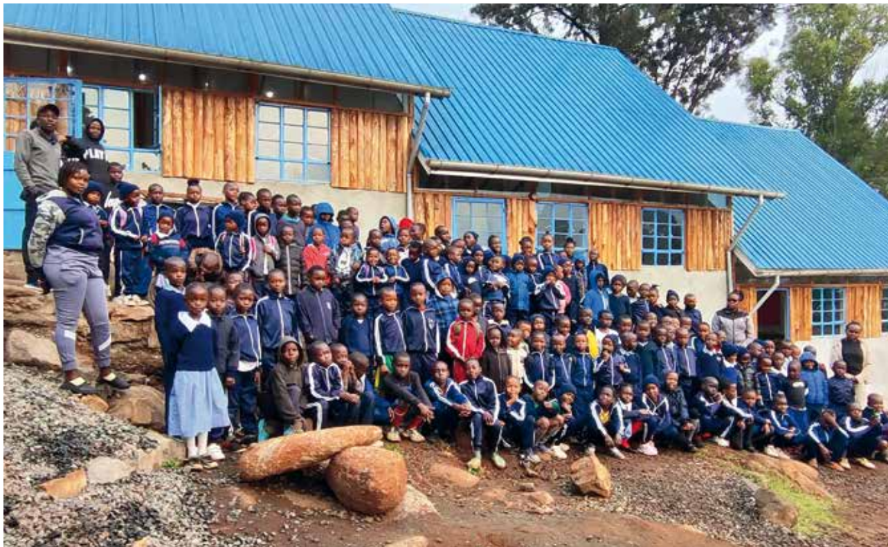
Im letzten Herbst hat ein von der Strasse abgekommener Lastwagen ein Schulgebäude zerstört. Nun freuen sich alle, die in kurzer Zeit neu erstellten Schulräume zu beziehen. (Bild zvg)
