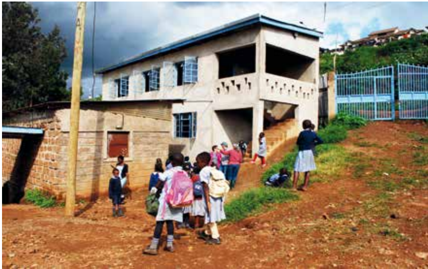
2018 konnte ein neues Gebäude mit zwei gemauerten Schulzimmern für die 6. und 7. Klasse erbaut werden.
